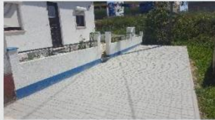
Colocação de pavê | Rua dos Abrunheiros
