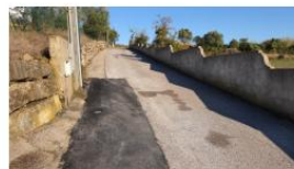
Rua da Liberdade | Montachique
