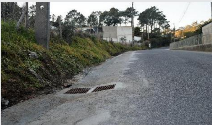
Requalificação de Bermas e valetas na Rua das Indústrias em Casais do Forno
